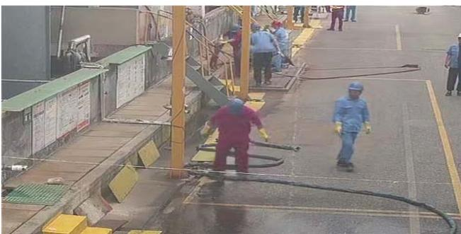
经张科相关指令后，杨东坡佩戴相关防护后，拿抹布，靠近 TK201 罐底阀，法兰泄漏点用抹布包裹泄漏点进行遮挡，减少 TK201 罐的泄漏量；同时开始切换相关阀门，把 TK201 罐的液碱倒灌排入 TK101 罐。
