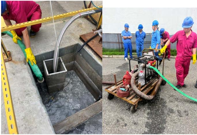
柴油机在碱罐区外围窨井进行取样检查，并开启柴油机进行转移窨井内的废水，排往应急收集雨水池，后通过潜水泵转移到综合污水池，进行污水处理。
